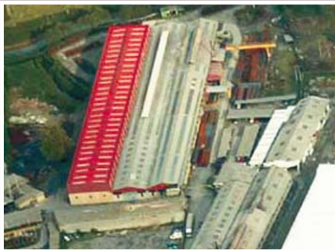
VISTA PLANTA • VIEW OF THE PLANT • LIEFERBEDINGUNGEN • VUE DE L'USINE.
